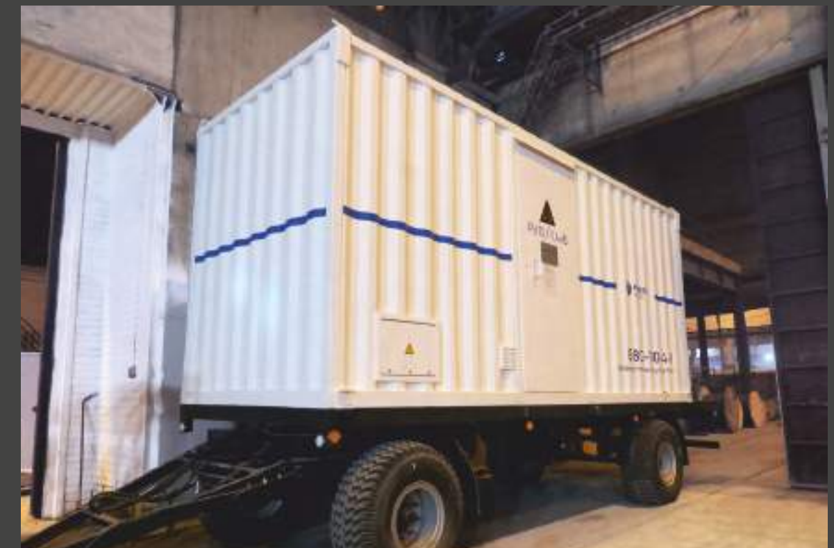
ПАО «Россети Ленэнерго» Центральный склад «Южные электрические сети» Передвижная контейнерная трансформаторная подстанция (ПКТП) 10(6) кВ 630 кВА
